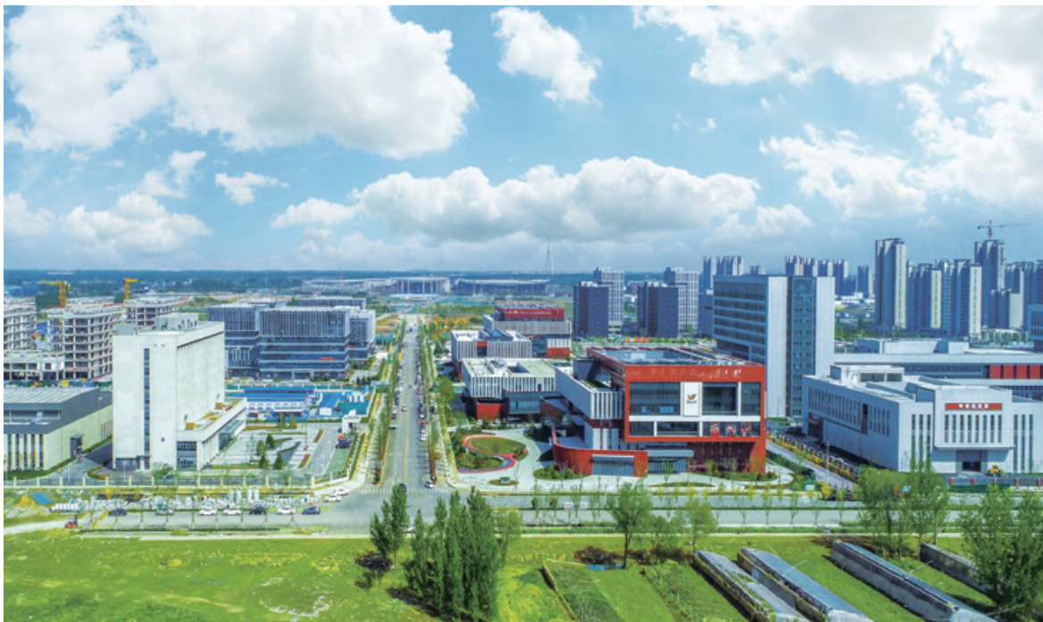
新旧动能转换起步区风貌
